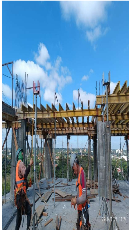
Encofrado y Cargamento de Losa
