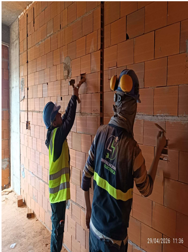
Colocación de cajitas de tomas en departamentos – Encofrado de losa
