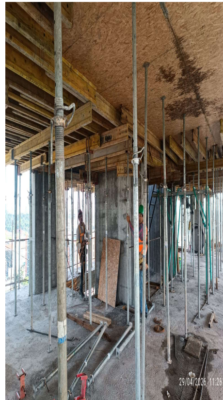
Colocación de cajitas de tomas en departamentos – Encofrado de losa
