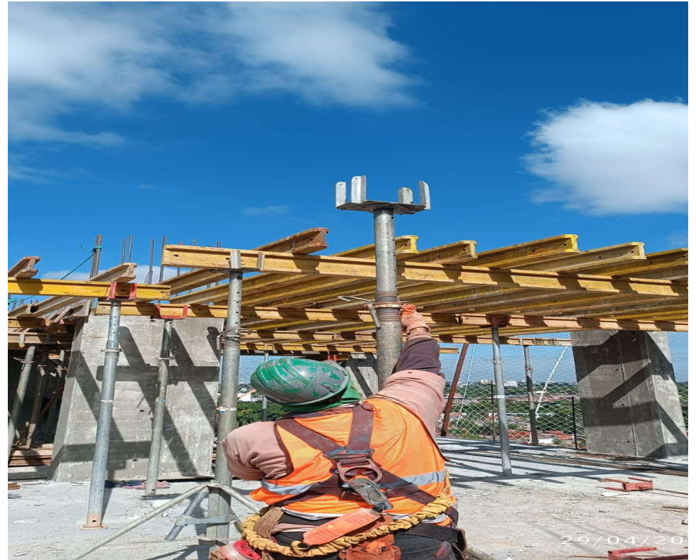
Encofrado y Cargamento de Losa
